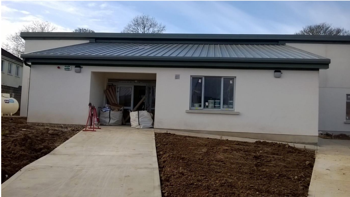
Extension at Coláiste an Átha
